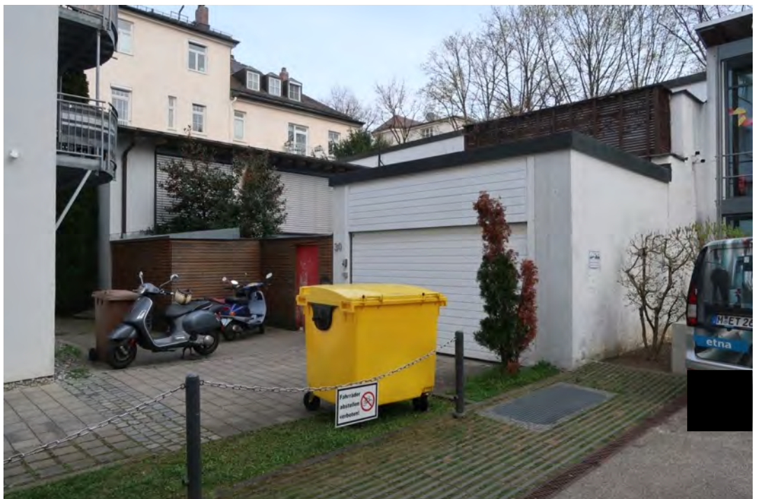
Bewertungsobjekt: Rückgebäude Kaiserstr. 30, Teileigentümer Nr. 12, 13 und 14
