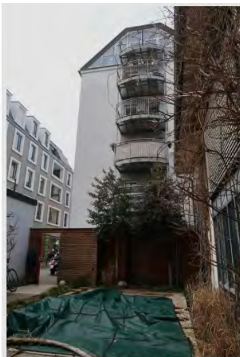
→ Blick in Richtung Vordergebäude
